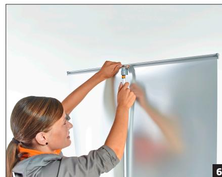
Installare lentamente e con cura la guida di fissaggio con la fessura sull'elemento in plastica dell'asta. È possibile allungare completamente l'asta telescopica fino a tendere perfettamente il tessuto. Allentare i singoli segmenti dell'asta telescopica, allungare l'asta e fissare di nuovo i segmenti.
